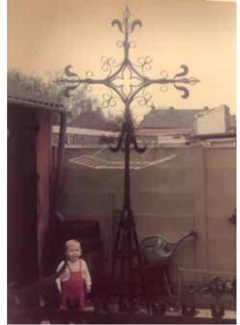
HET TORENKRUIS NA RESTAURATIE IN VOLLE GLORIE IN DE ACHTERTUIN, 1978, COLLECTIE JOSÉ VAN BROEKHOVEN-WAARMA
