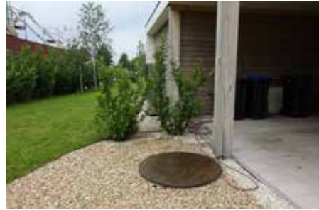
De gemetselde put van de voormalige boerderij, vlak naast de carport, met afdekplaat
