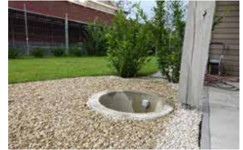
Voor de foto graaf werd de afdekplaat even weggehaald
